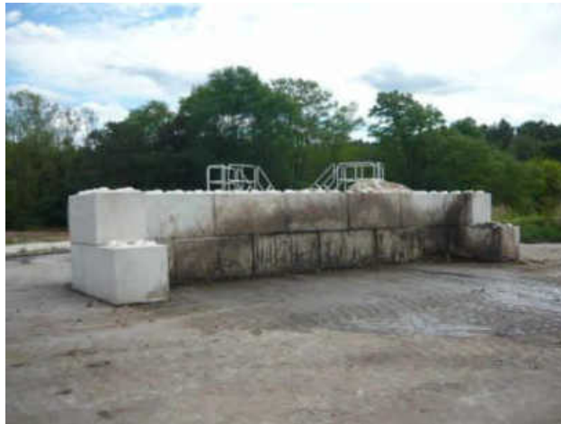
Im August 2020 wurde die Umladebox aus Formbetonsteinen neu errichtet.
