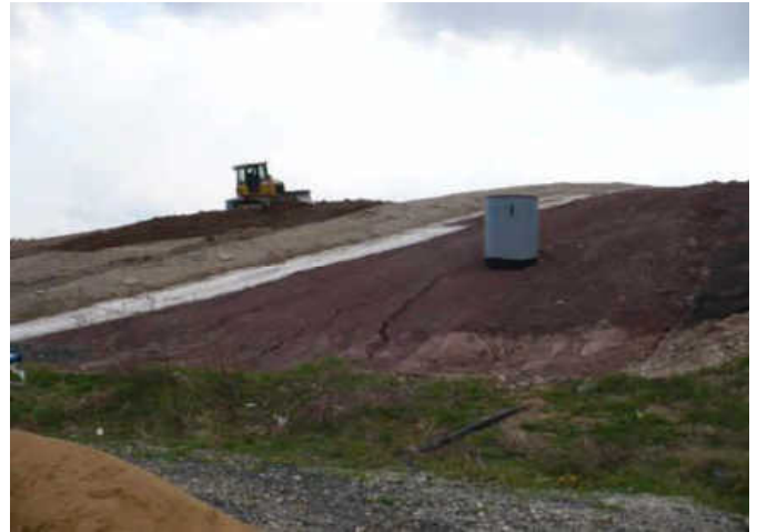
Bauarbeiten zur Aufbringung der temporären Oberflächenabdichtung am Entsorgungszentrum Schwabach (aufgenommen im April 2008).
