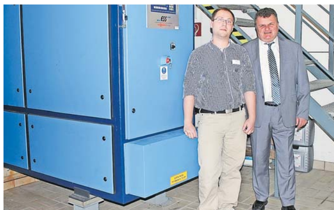
Geschäftsführer Diakon Klaus Seitzinger (r.) und Lee Schäfer, Leiter der Abteilung Technik und Medizintechnik, vor dem Blockheizkraftwerk.
