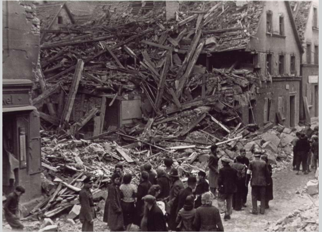
Beschädigungen nach dem Bombenangriff auf Schwabach
