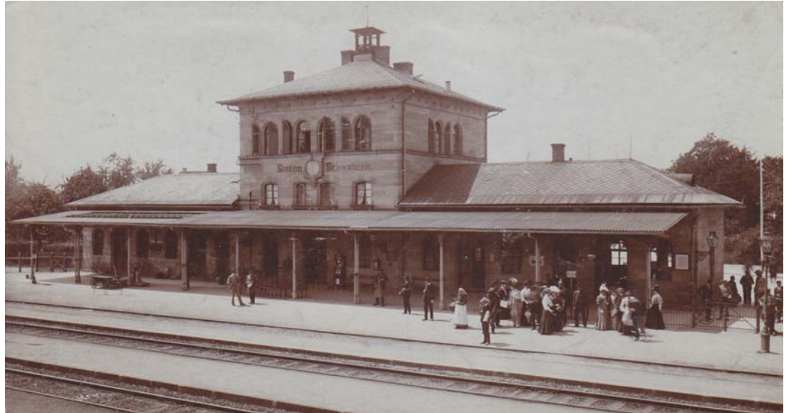
Das Haupthaus des Bahnhofs mit den Wartesälen
