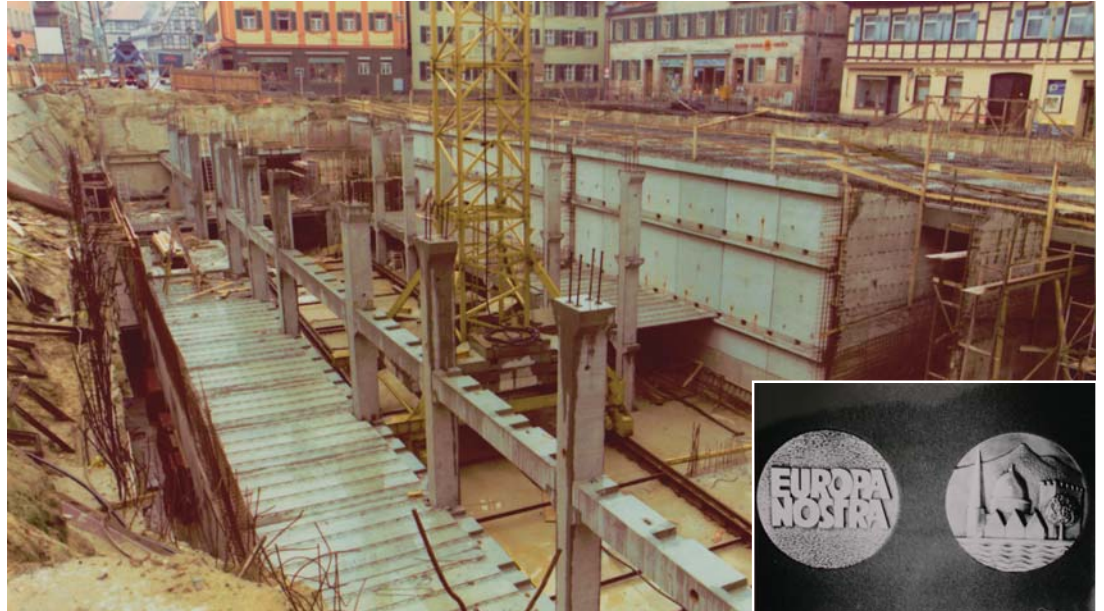
Wie eine Operation am offenen Herzen mutete der Bau der Tiefgarage unter dem Marktplatz an. (Schwabach erhält 1979 die Europa-Nostra-Medaille für vorbildliche Altstadtsanierung und Konzeption der Innenstadt, kl. Foto)
