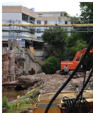
Nach dem kompletten Abbruch folgt nun der Bau der neuen Brücke über die Schwabach.
