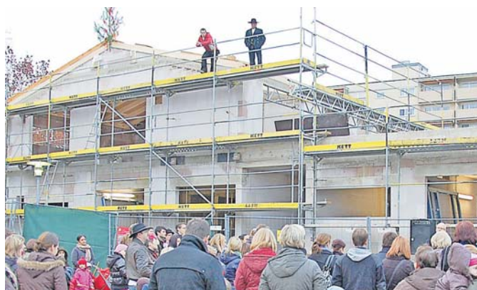
In den Bau von Kindertageseinrichtungen wurde viel investiert.
