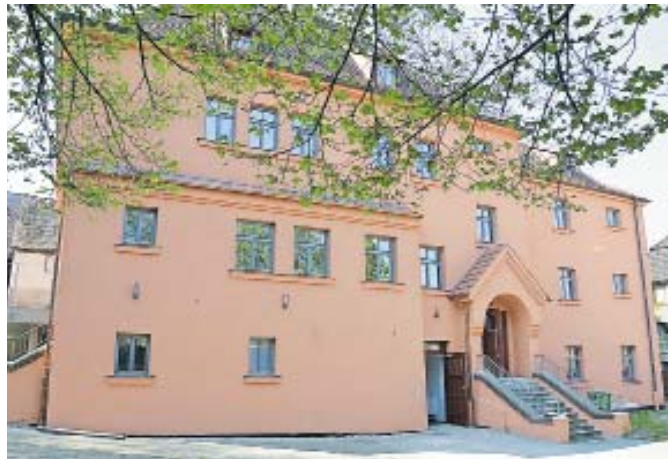
Freundlich und einladend ist das Gebäude in der Königsstraße 20 a geworden. Das Jugendzentrum (Juze) bleibt Hauptnutzer.
