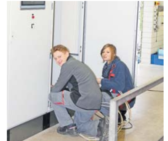
Michael Seger und Nicole Schmidt, Auszubildende bei den Stadtwerken, halfen beim Umbau der Technik im Parkbad mit.
