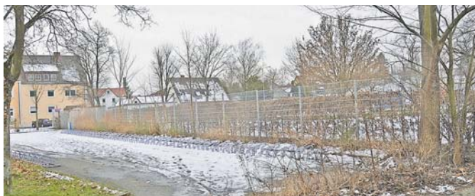
Direkt neben dem Parkbad entsteht das neue Hallenbad.
