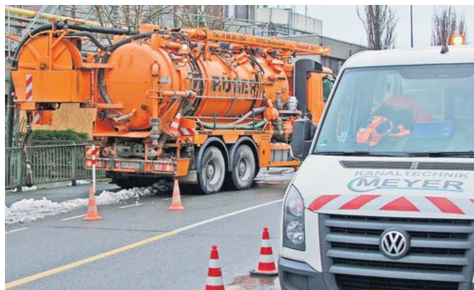
Mit Spülfahrzeugen wurden die Kanäle vor der Kamerafahrt bereits gereinigt.
