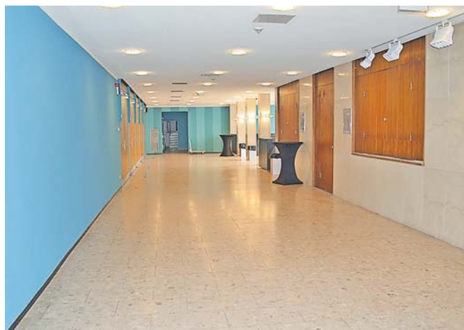
In neuem Glanz erstrahlt bereits das Markgrafensaal-Foyer.
