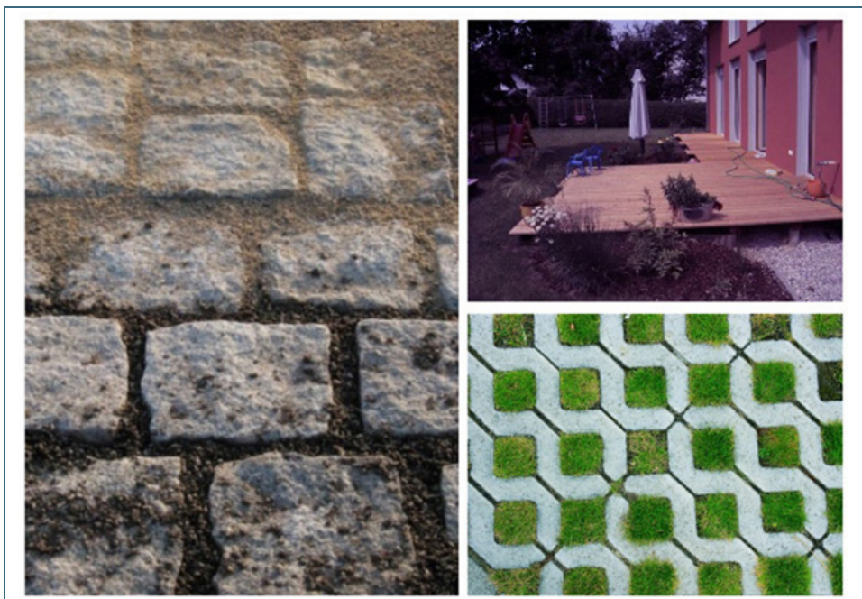
Abb. 5: Durchlässige Flächenbeläge sind z. B. Rasengittersteine (rechts unten) oder Kopfsteinpflaster mit Kiesschüttung (links) in Einfahrten oder Holzrosten auf Terrassen (rechts oben).
