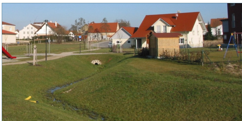
Abb. 7: Eine oberflächige Ableitung begünstigt die Verdunstung und ist kostengünstiger als unterirdische Anlagen.
