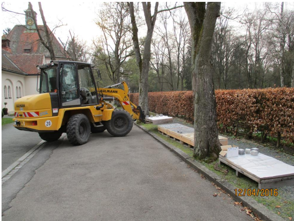
Aufbau von Musterpflasterflächen für die geplante Neugestaltung im Waldfriedhof
