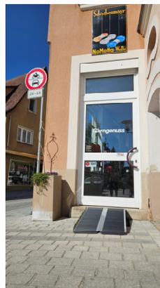
Die Länge der Rampe errechnet sich an der Höhe der Stufe / der Stufen. Der Steigungswinkel sollte möglichst flach sein (6 % Steigung). Andernfalls ist Hilfe durch einen Dritten notwendig.
