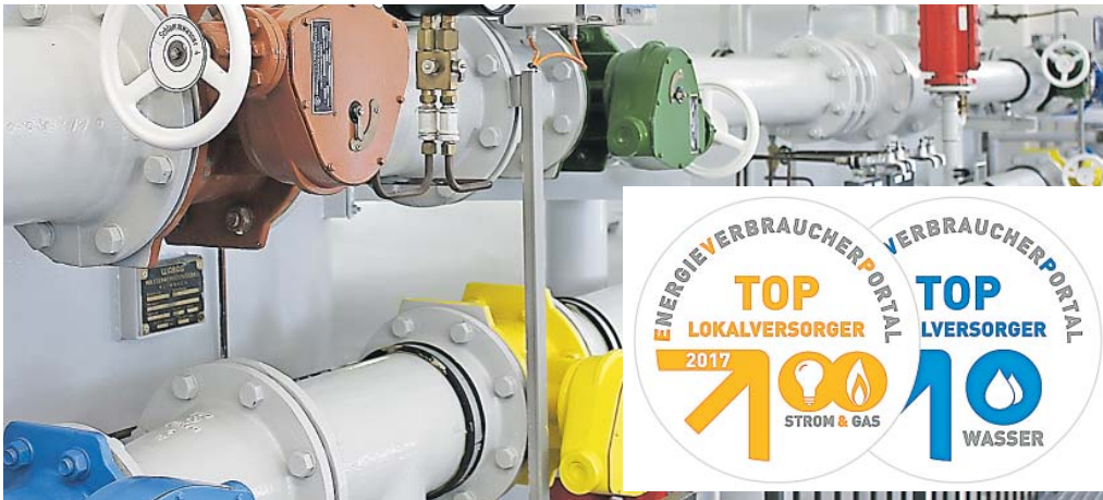
Blick ins Wasserwerk in der Brünst: Sowohl beim Wasser als auch bei Strom und Gas sind die Stadtwerke top.
