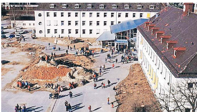
Die Baustelle bei der Neugestaltung des SFZ-Schulhofes
