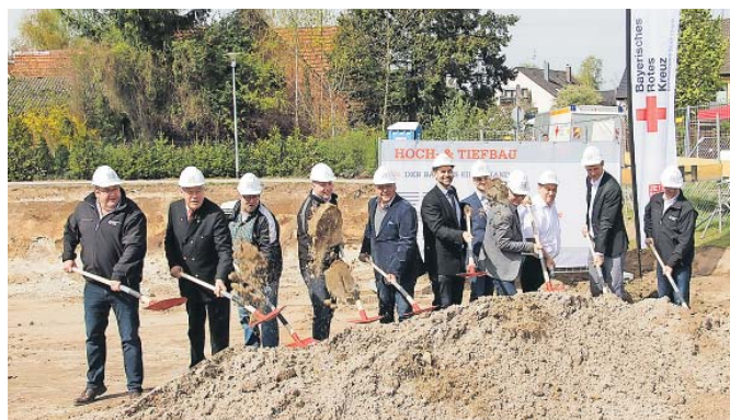
Die ersten buddelten schon im Sand - beim Spatenstich für den Neubau.
