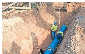
Umverlegung der Wasserleitung
