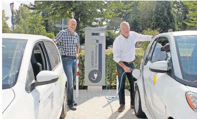
Stadtbaurat Ricus Kerckhoff (rechts) und Stadtwerke-Geschäftsführer Winfried Klinger testen die neue Ladesäule am Parkplatz beim Parkbad. Zwei Parkplätze sind hier für E-Autos reserviert.
