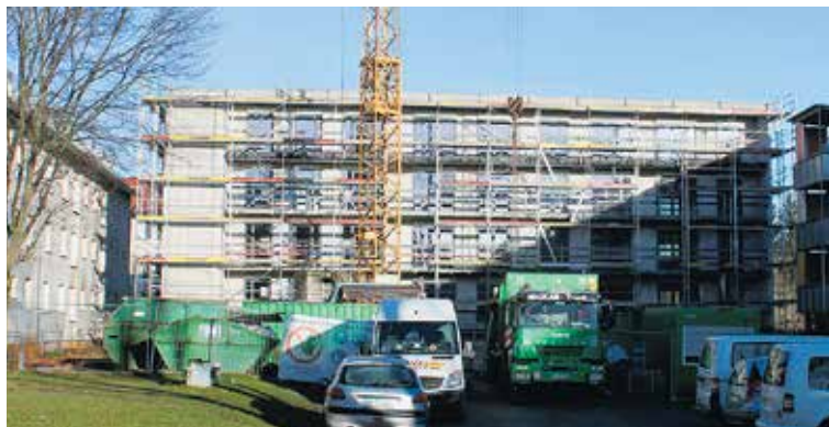
Auch Fenster sind schon eingebaut: Der von Bernd-Dieter Jesinghausen ermöglichte Neubau in der Konrad-Adenauer-Straße nimmt Formen an.
