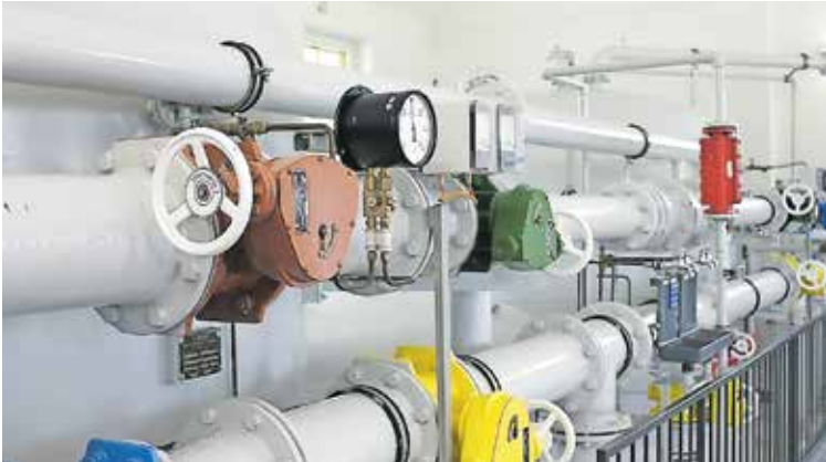
Das Wasserwerk in der Brünst wurde 1987 gebaut.
