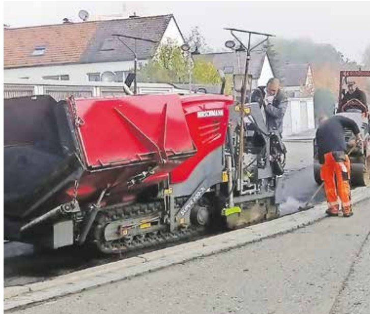
Die Straßenbaumaßnahme im Eichwasen hat sich verzögert. Mit den Asphaltierungen noch im Dezember zu beginnen, war nicht möglich.
