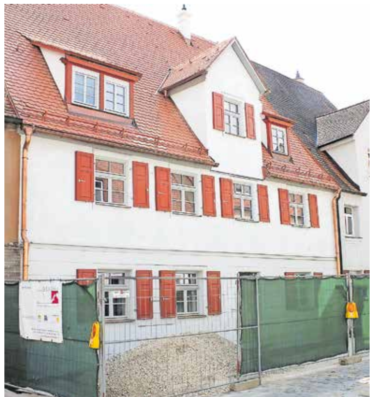
Neuer Glanz in der Benkendorferstraße: Die Sanierungsarbeiten an der Nummer 13 sind fast abgeschlossen. Im September ziehen Mieter ein.
