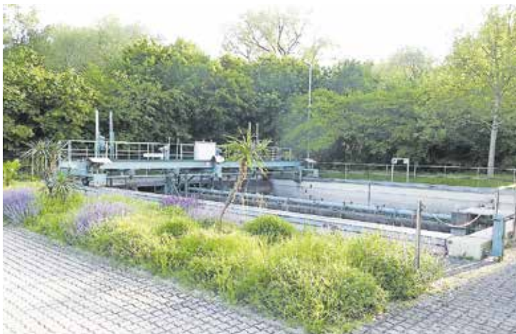
Der Sandfang in der Kläranlage
