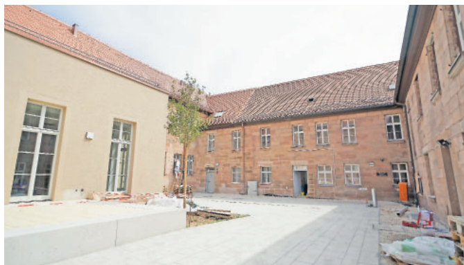
Links entsteht die neue Terrasse vor dem AWO-Saal. An den Planungen für die ehemalige Musikschule (rechts) im Rahmen des 2. Bauabschnitts wird bereits gefeilt.
