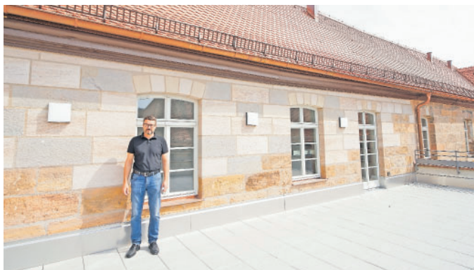
Knut Kosmann, Leiter der Technischen Abteilung bei der GEWOBAU, begutachtet bei einem Baustellentermin die neue Dachterrasse der Kinderpflege-Schule, die auch als Pausenhof genutzt werden darf.
