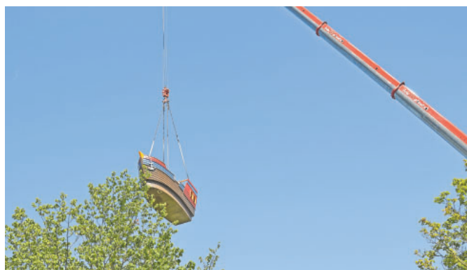
3,5 Tonnen wiegt das Piratenschiff, dank des Schwerlastkrans schwebte es von der Straße über den angrenzenden Fußweg in den Garten des „Haus für Kinder Altstadt“.
