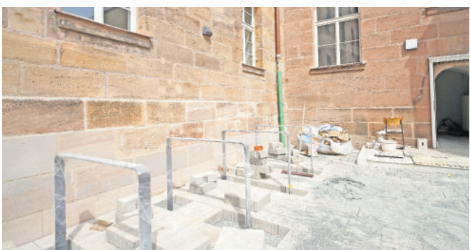
Die Pflasterarbeiten im Innenhof waren Ende Juli bereits in den letzten Zügen.
