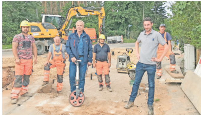
Mittlerweile ist die Straße wieder gefüllt und befahrbar – Über die erfolgreiche Umsetzung freuen sich Philipp Vockentanz von den Stadtwerken Schwabach (2. von rechts) und Robert Löffler von der Firma Nibler (3. von links) mit einem Teil des Bau- und Projektteams.
