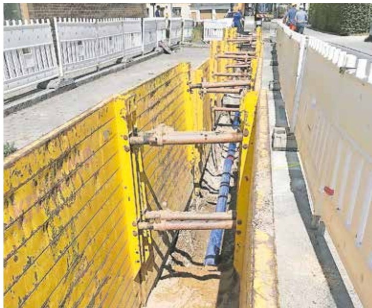
Die Baumaßnahme im Ortsteil Schaftnach
