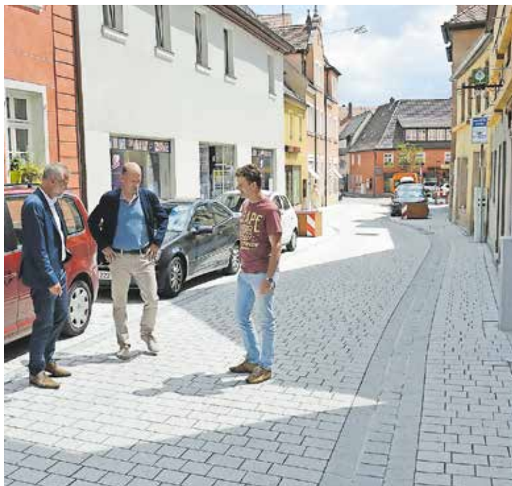
Stadtbaurat Ricus Kerckhoff, Tiefbauamts-Leiter Jürgen Barthel und Projektleiter Jörg Maier begutachten den neuen Straßenbelag in der Friedrichstraße.
