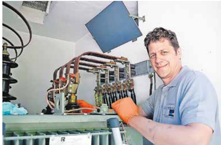
Stadtwerke-Elektrofachkraft Jürgen Gerstner bei der Wartung einer Mittelspannungsstation.
