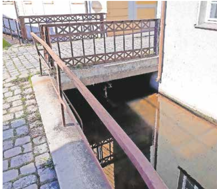
Brücke in der Münzgasse
