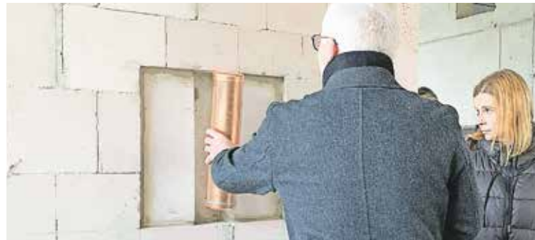
Der Unterreichenbacher Pfarrer Werner Konnerth legt eine Zeitkapsel in den Grundstein ein.
