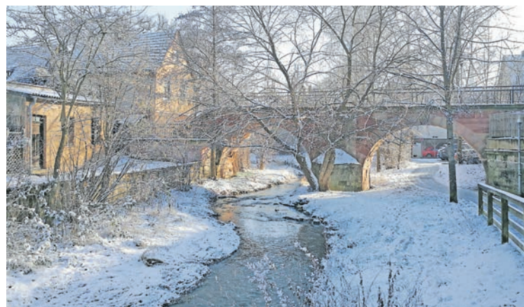
Die Sandstein-Bogenbrücke prägt das Bild der westlichen Altstadt: oben bei der Sanierung im Jahr 1965, unten wie sie heute aussieht.
