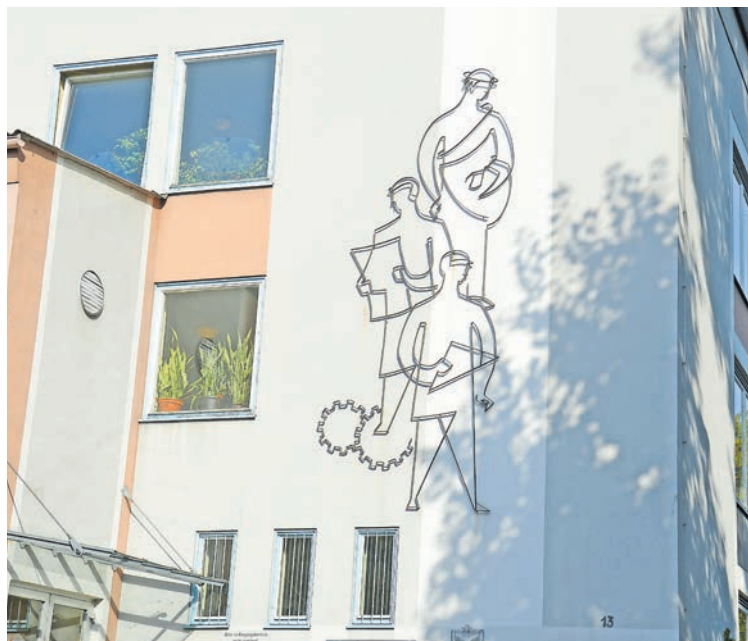
In das ehemalige Gebäude der staatlichen Berufsschule wird ebenfalls investiert.
