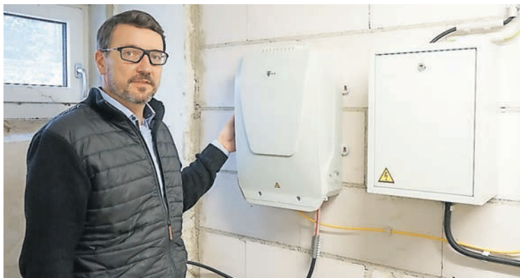
Glasfaser bis ins Gebäude: Knut Kosmann, Prokurist bei der GEWOBAU, zeigt die neuen Übergabe-Punkte für das TV-Signal.
