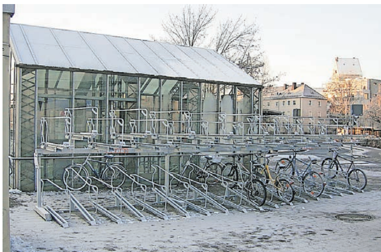
Selbst bei Winterwetter werden die neuen Radstellanlagen am Schwabacher Bahnhof genutzt.
