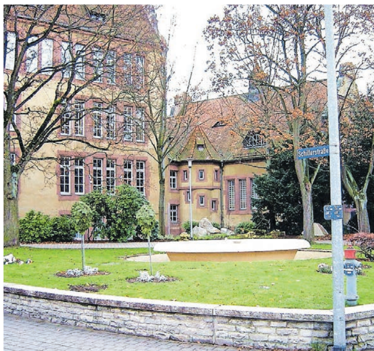
Der alte Brunnen am Schillerplatz ist marode. Wasser soll auch in Zukunft bei der Platzgestaltung eine Rolle spielen.
