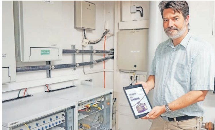
Komplexe Verkabelung – jedes Gründerbüro im SCHWUNG verfügt nun über einen eigenen Glasfaseranschluss.
