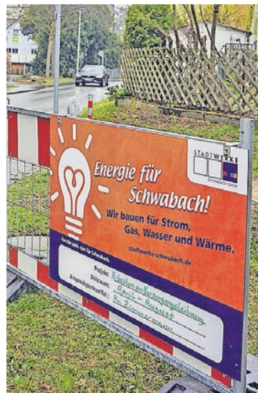
In der Rotenbergstraße und Am Leutzmannshof werden Versorgungsleitungen erneuert.
