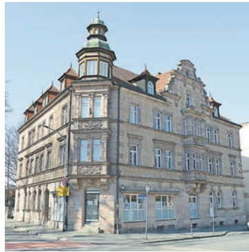
Das Gebäude in der Eisentrautstraße 2
