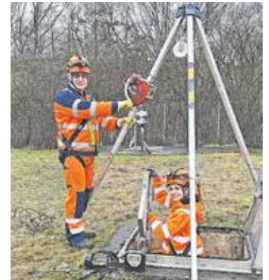
Einstieg in den Abwasserkanal
