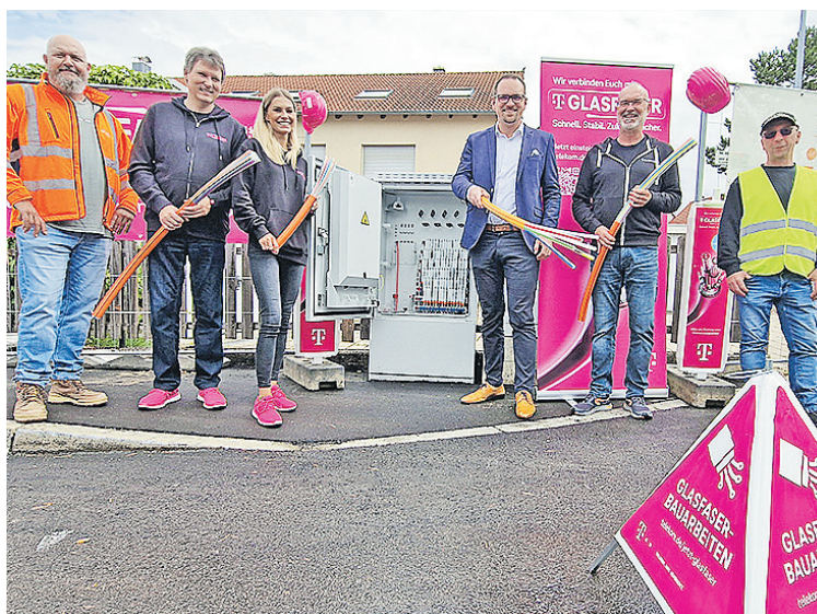
An der Ecke Äußere Rittersbacher/ Forstersbühl wurden die ersten Kabel verlegt. Stefan Hecht (Bereichsleiter, circet Deutschland), Markus Sand (Kommunalberater Glasfaser, Telekom), Maxi Byncz (Vertrieb, Telekom), Bernd Glaubitz (Vertrieb, Telekom), Manfred Dalügge (Bauüberwachung, circet) (von links) informierten Oberbürgermeister Peter Reiß (3. von rechts).
