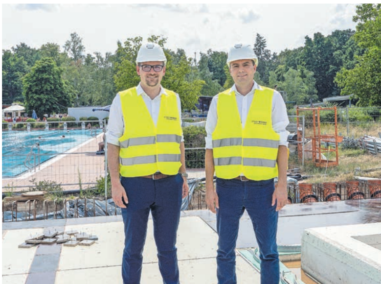
Oberbürgermeister Peter Reiß (l.) und René Lukas machten sich ein Bild vom Baufortschritt auf der Hallenbad-Baustelle.
