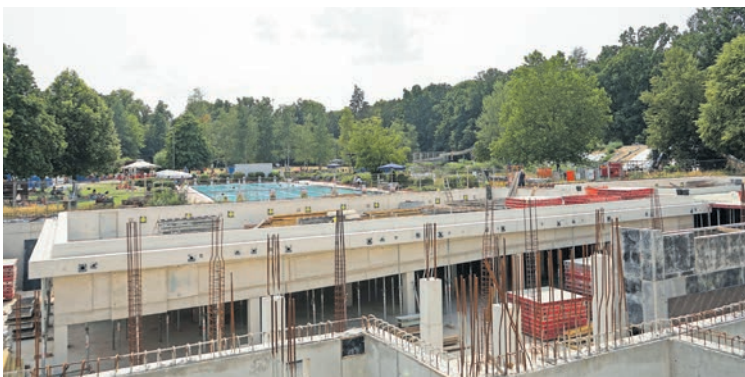
Die Schwimmbecken sind in der Entstehung.
