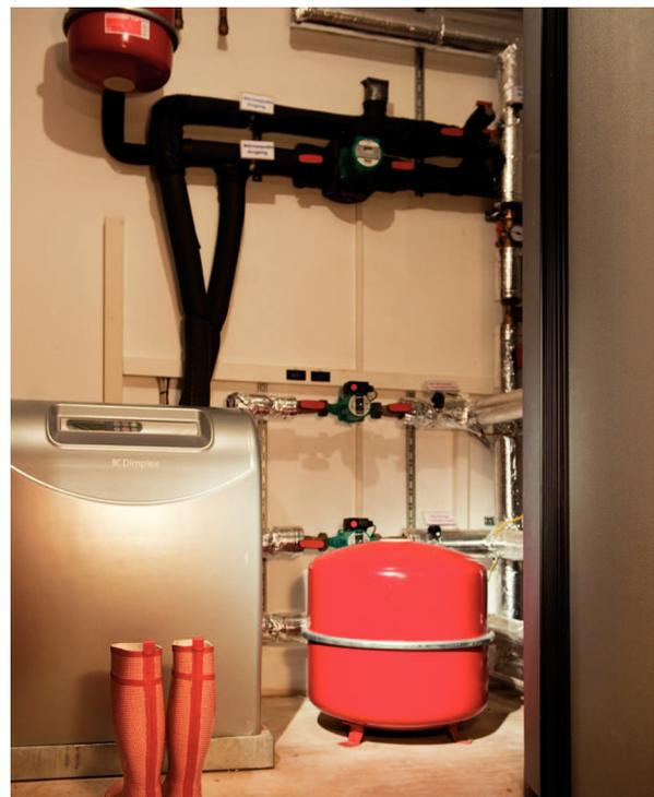
Abb. 10: Wärmepumpenheizung (Quelle: BWP)
