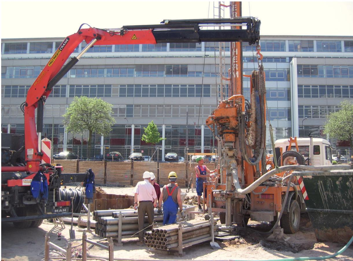
Abb. 2: Bohrung für Erdwärmesonden (Quelle: BWP)
