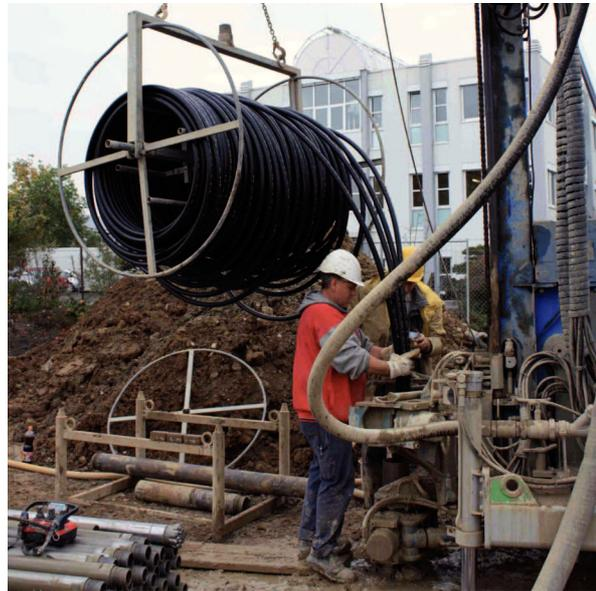
Abb. 7: Einbringen einer Erdwärmesonde (Quelle: LfU)
