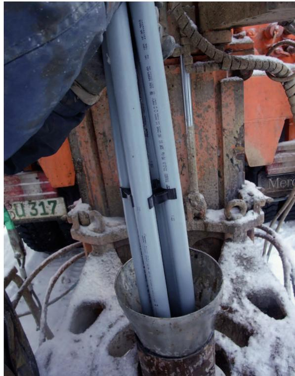
Abb. 8: Einbringen einer Erdwärmesonde mit Innenabstandshalter (Quelle: LfU)
