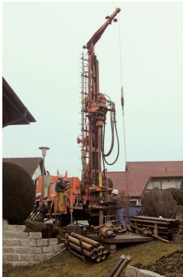
Abb. 1: Bohrung für Erdwärmesonden (Quelle: LfU)
