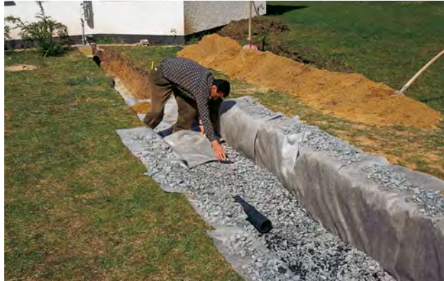
Abb. links: Anschluss des Versickerungsrohrs.
