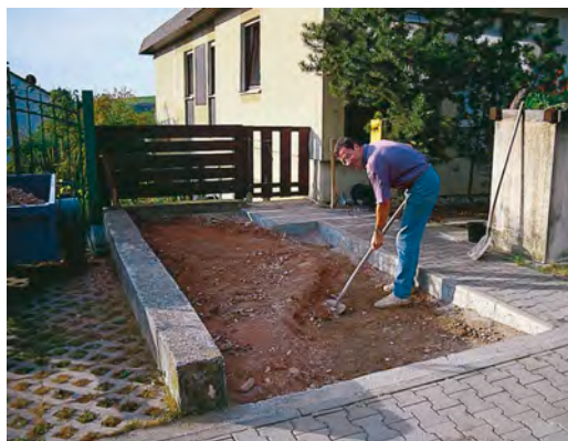
Abb. links: Randsteine setzen.
