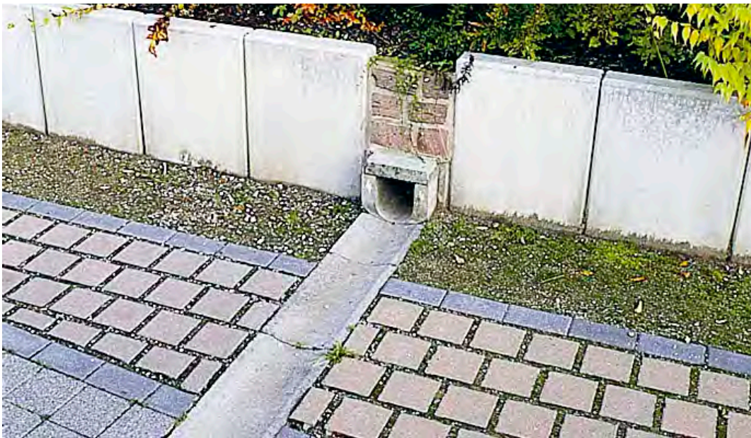
Abb.: Überlauf, Regenwasser- speicher in Mulde.
