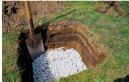
Abb. links oben: Ausheben der Grube.
