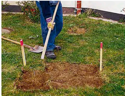
Abb. links: Abstecken der Baugrube.
