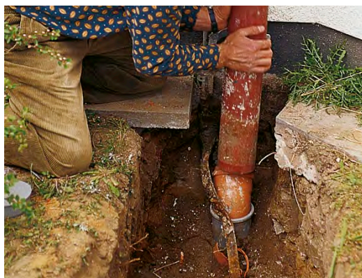
Abb. rechts: Anschluss an Hofablauf.
