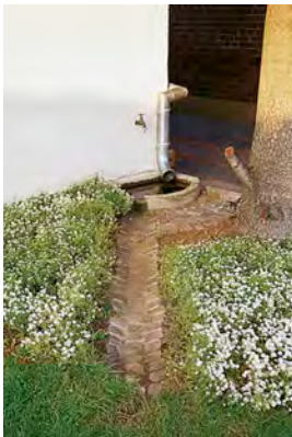
Abb. oben: Regenwasserversickerung in einer Mulde.
