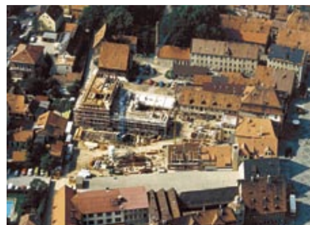
Baustelle Bürgerhaus I im Sommer 1982
