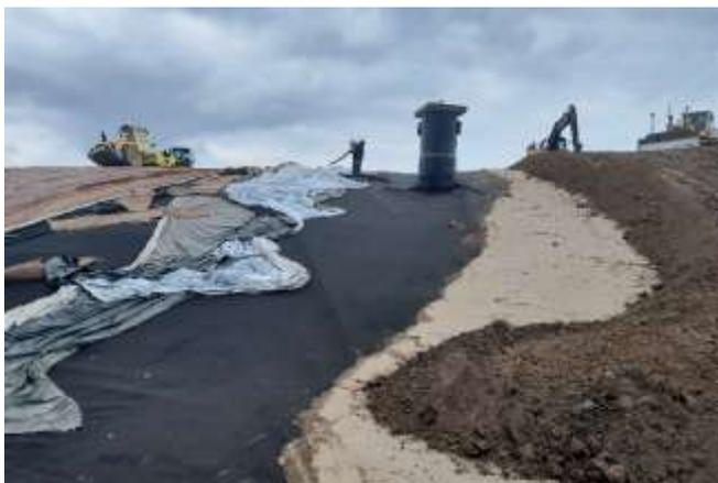
Die Gasbrunnen und Sammelleitungen wurden freigelegt. Stromkabel, die bisher in den Deponieflächen verlegt waren, wurden mit neuer Kabeltrasse außerhalb der Deponieflächen verlegt.
