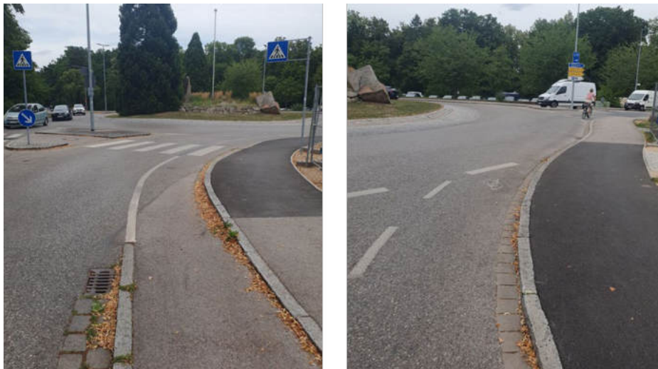
Abbildung 15: Radverkehrsführung am Kreisverkehr Angerstraße/ Lindenstraße (Quelle: eigene Aufnahme)
