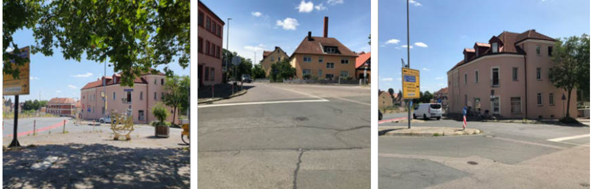
Abbildung 62: Knotenpunkt Innenstadtzugang am Nördlinger-Tor-Platz im Bestand (mit Blickrichtung (v. rechts n. links) Südosten, Westen, Osten)
